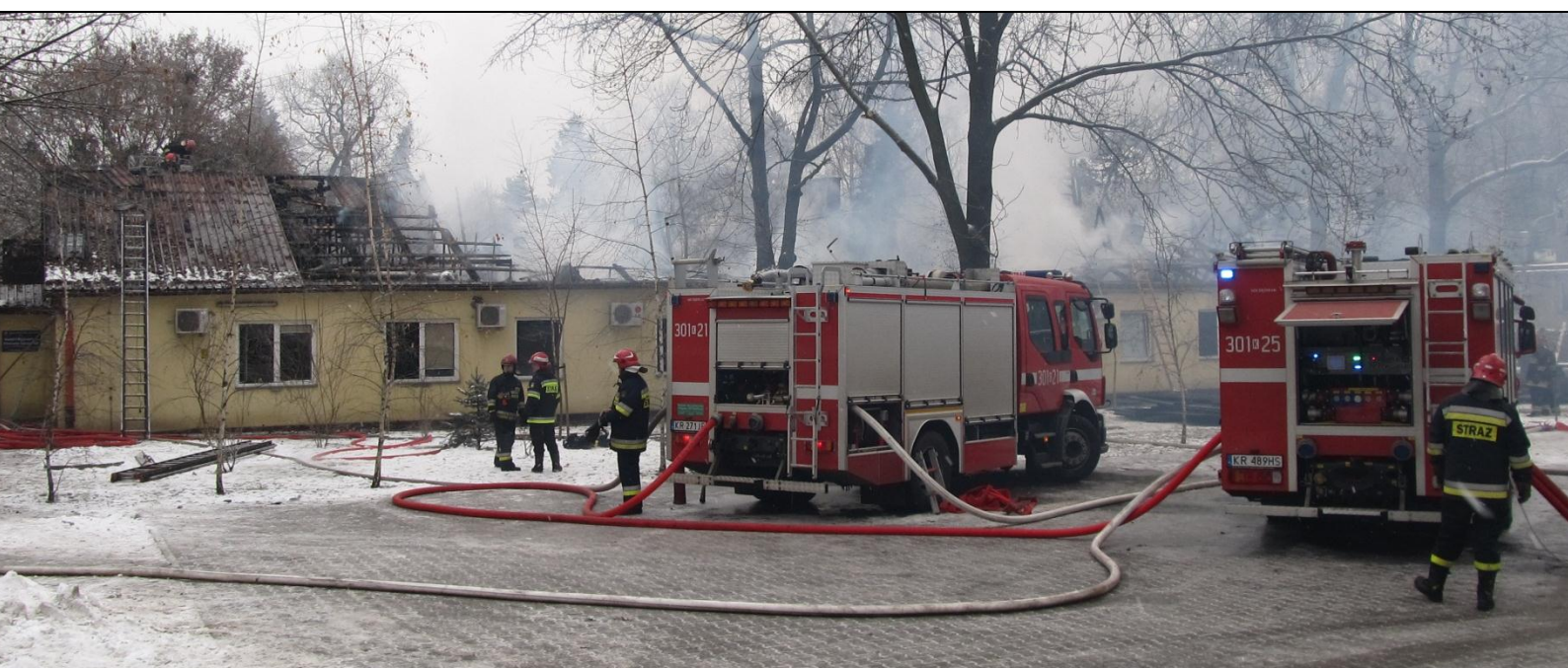
Pożar budynku Zakładów Mikrobiologii oraz Toksykologii Szpitala Uniwersyteckiego, ul. Śniadeckich, 10.12.2012, rejon działania JRG 1
