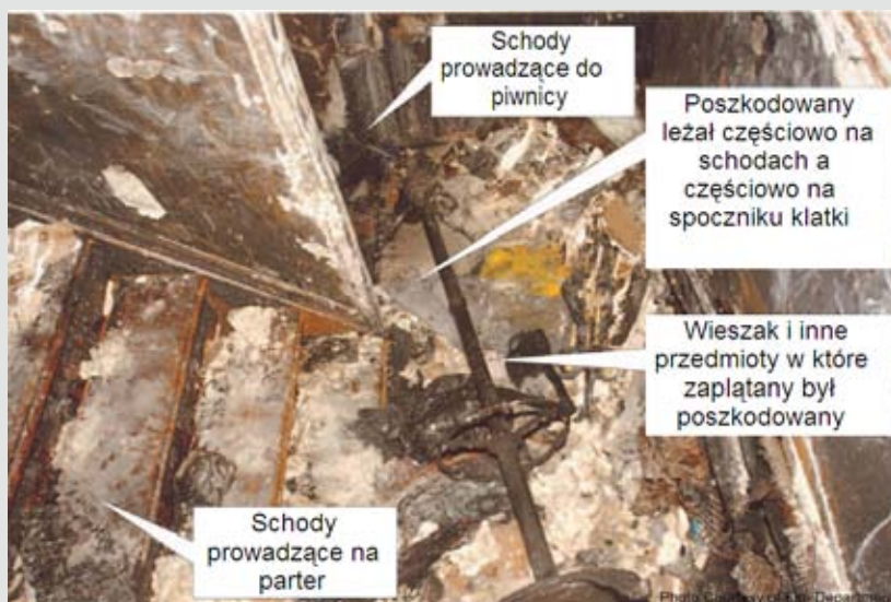
Fot. 7.2. Miejsce odnalezienia poszkodowanego na spoczniku klatki schodowej prowadzącej do piwnicy. (Zdjęcie: NIOSH Report F2005/04, http://www.cdc.gov/niosh/fire ). [1]
