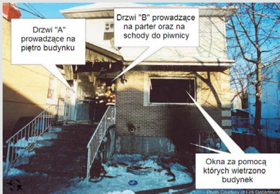
Fot. 7.1. Front budynku objętego pożarem.
