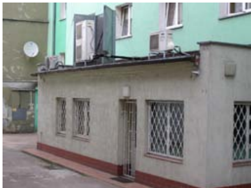
Fot. 4.13. Kraty w oknach pomieszczeń znajdujących się od tyłu budynku mogą utrudnić dotarcie do poszkodowanego strażaka.
