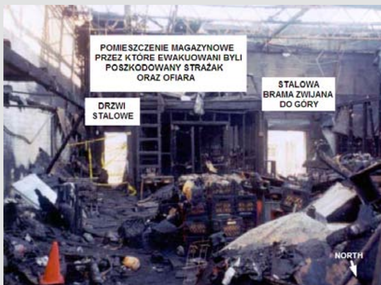
Fot. 6.3. Pomieszczenie magazynowe.
