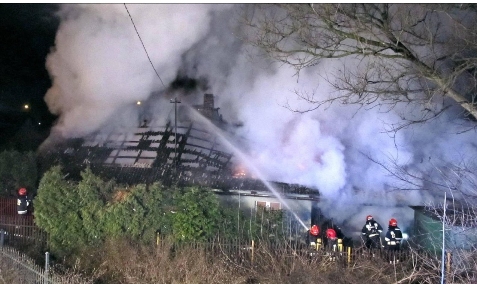
Pożar budynku mieszkalnego – ul. Powiatowa, 17.12.2014 r.
