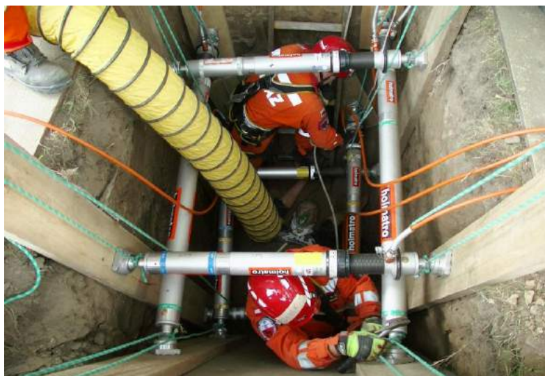
Szkolenie z zakresu stabilizacji wykopów i zasypów ziemnych
