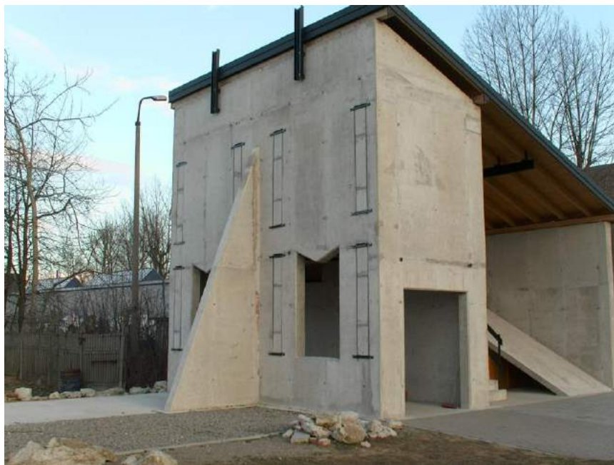
Zdj. 6. Stanowisko treningowe ST-3
